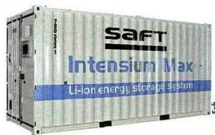
la batterie Intensionium Max de Saft, d'une puissance de 2 MW, pouvant restituer 1,3 MWh, associée à l'Energy Storage Box de Schneider Electric. Cet ensemble permet de gérer les échanges avec le réseau électrique en tenant compte des prévisions de production et de consommation du lendemain. ●
